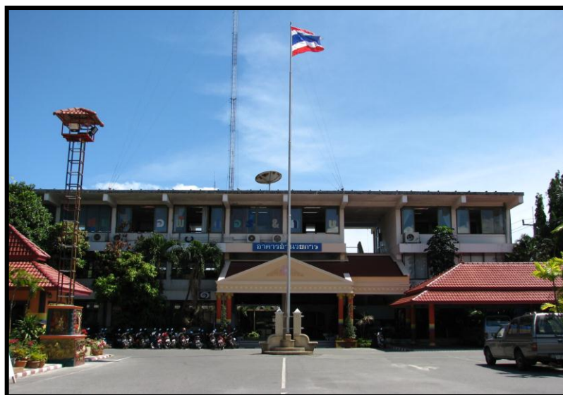
อาคารอำนวยการ
